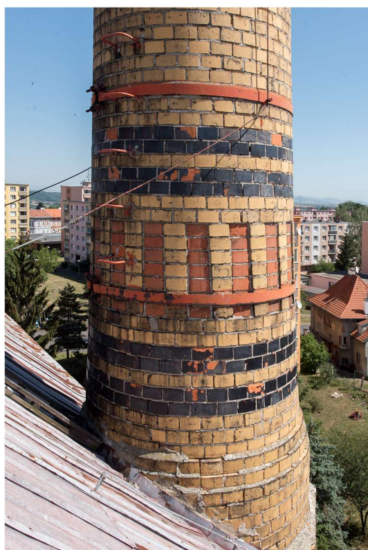
Obr. 30: Ornament na komíně skladu čp. 1186 (pasport č. 25).
