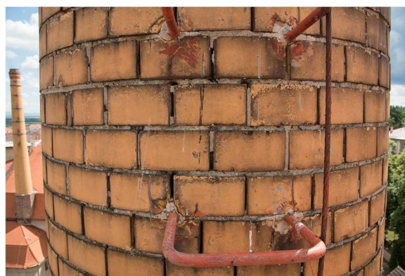
Obr. 29: Žluté lícové komínovky u oblého dříku komína skladu čp. 753 (pasport č. 27).
