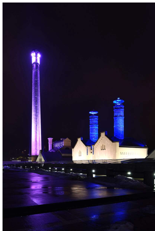
Obr. 66: Noční nasvětlení komínů bývalého pivovaru v Děčíně přestavěného na obchodní centrum. Zdroj: Archiv Fabriky.cz, neinventarizováno.
