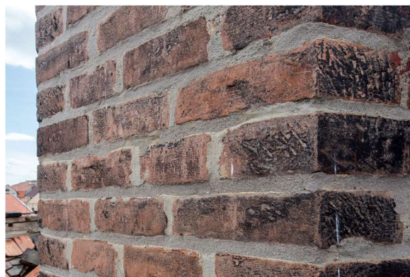
Obr. 22: Zdivo oktogonálního dříku komína skladu čp. 380 (pasport č. 03).
