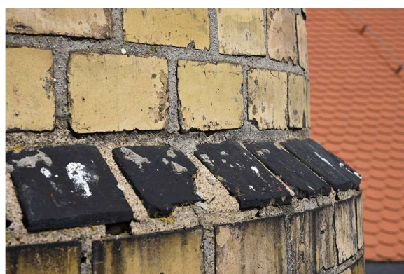
Obr. 27: Tvarovky použité v rámci soklu dříku komína skladu čp. 1950 (pasport č. 18).
