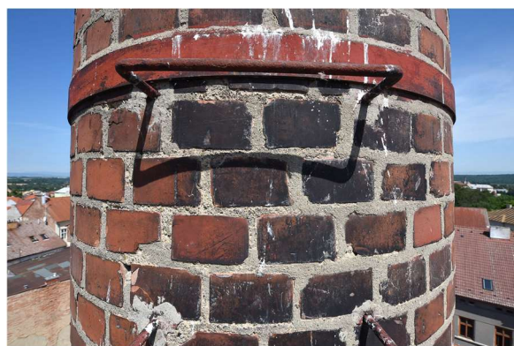
Obr. 28: Zdivo oblého dříku z červených komínovek hvozduvého komína skladu čp. 3040 (pasport č. 17).
