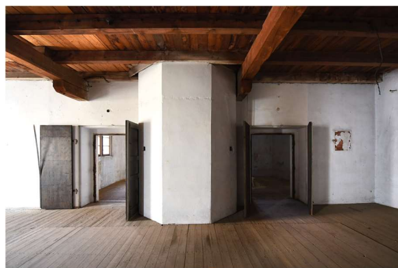
Obr. 18: Podstavec jako součást zdiva, které vymezuje prostor sirných komor ve skladu čp. 1232 (pasport č. 28).
