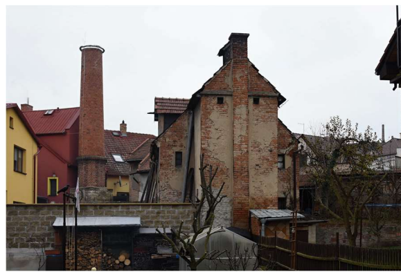
Obr 4: Dochovaný sušárenský hvozď při čp. 1217 vybudovaný roku 1927. Objekt má typické znaky pro tento typ staveb (komín v čele stavby a střešní párník. Komín vlevo s chmelařským provozem nesouvisí, sloužil provozu pekárny).
