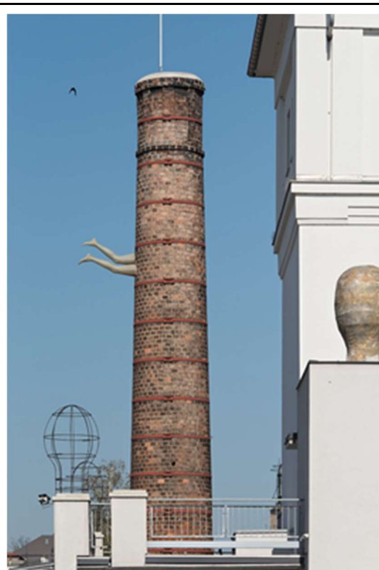
Obr. 67: Drážní vodárna v Opavě byla přebudována na galerii s kavárnou. Na její komín byla osazena skulptura svítících nohou od Kurta Gebauera. Zdroj: Archiv Fabriky.cz, neinventarizováno.
