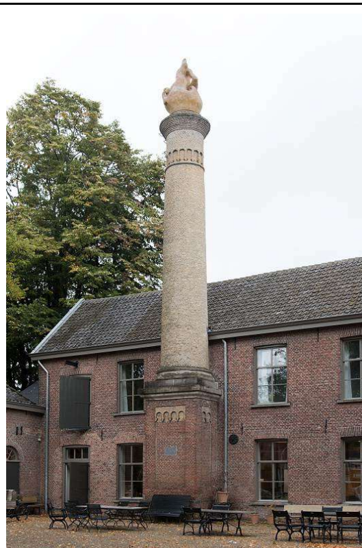
Obr. 68: Znovuvystavěný dřík komína s osazenou plastikou v podobě plamene ve tvaru dábla v bývalé přádelně (dnes kulturním centru) v nizozemském Tilburgu. Zdroj: Archiv Fabriky.cz, neinventarizováno.
