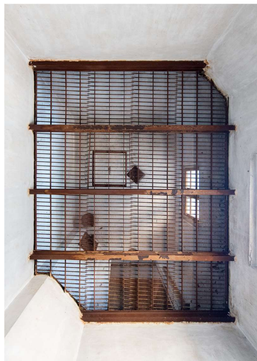
Obr. 34: Sirná komora ve skladu čp. 1232, vlevo dole komín prostupující komorou (pasport č. 28).
