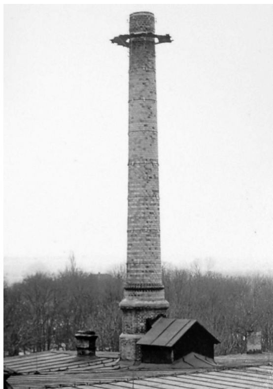
Obr. 56: Snášení továrního komína nad někdejší chmelařským skladem Sonnenschein & Landesmann (čp. 1907) v roce 1977. Zdroj: URBAN, nedatováno, nestránkováno (repro).
