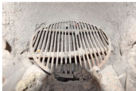
Obr. 43: Při terénních průzkumech byl v horní části podstavce nalezen pouze plochý rošt (ve skladu s dnešním čp. 305). Patrně ale taktéž sloužil pro vkládání neutralizačních prostředků (pasport č. 29).
