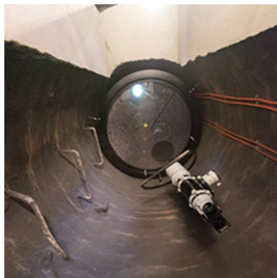
Obr. 74: Periskop v nitru komína věžového vodojemu letenské vodárny v pražské Bubenči. Zdroj: Archiv Fabriky.cz, neinventarizováno.
