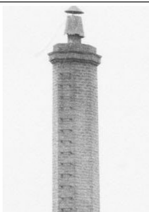
Obr. 46: Typ deflektoru typický pro žatecké chmelařské komíny. Zde konkrétně na komíně skladu při čp. 225 na počátku 20. století (komín byl později snesen). Zdroj: Sbírka Regionálního muzea K. A. Polánka v Žatci, Fn0276 (upraveno, výřez).
