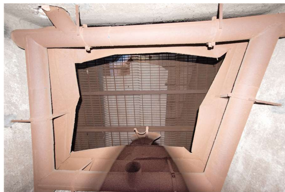
Obr. 39: Topné roury v topeništi sirné komory pod spodní lískou ve skladu čp. 1232 (pasport č. 28).
