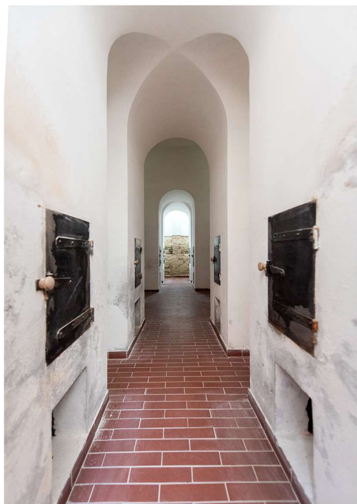
Obr. 33: Topeniště ve spodní části sirné komory ve skladu dnešního čp. 305 (pasport č. 29).
