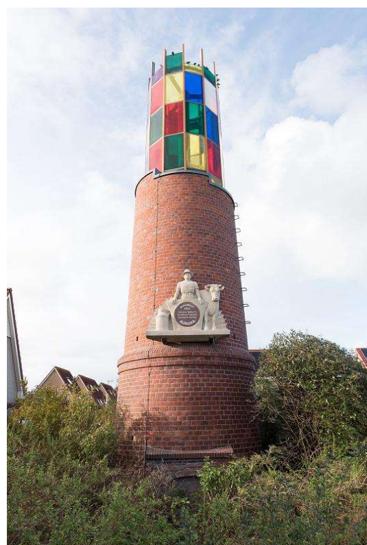
Obr. 71: V nizozemském Opmeeru zbylo torzo komína jako jediný pozůstatek po místní mlékárně. Torzo bylo později přebudováno na památník upomínající na zdejší slavnou mlékářenskou historii. Zdroj: Archiv Fabriky.cz, neinventarizováno.
