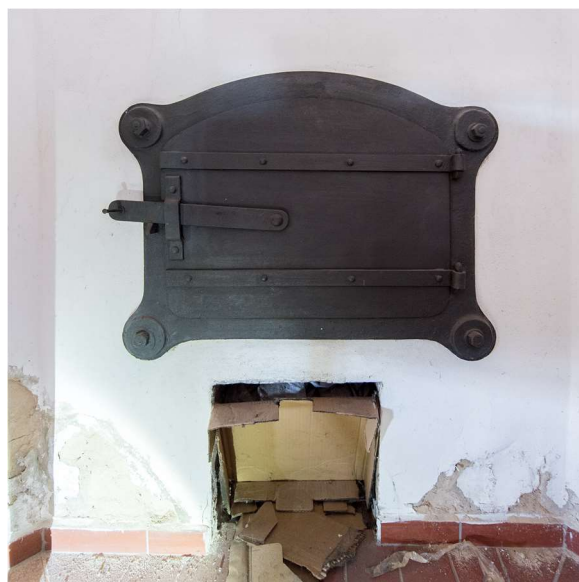
Obr. 51: Topeniště v patě komína ve skladu s dnešním čp. 1950 (pasport č. 18).
