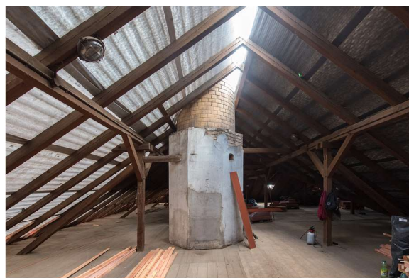
Obr. 19: Podstavec volný ve svém půdorysu – prostor nad sirnými komorami ve skladu čp. 1192 (pasport č. 26).
