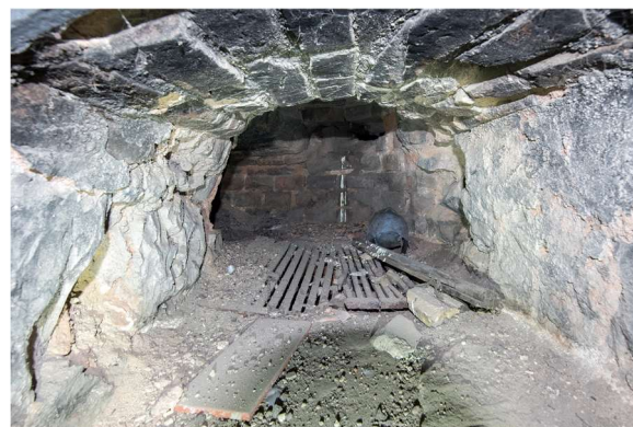
Obr. 52: Rošt v topeništi v patě komína ve skladu s dnešním čp. 1950 (pasport č. 18).
