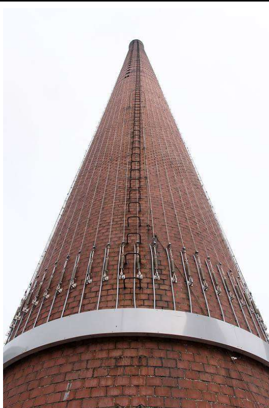
Obr. 65: Detail komína technické univerzity v Eindhovenu, který je osazen LED osvětlením umožňujícím dynamické animace (při dálkových pohledech rozvody vzhled komína příliš neruší). Zdroj: Archiv Fabriky.cz, neinventarizováno.
