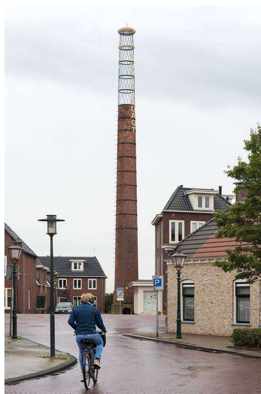
Obr. 72: Ocelová nástavba doplňující původní tvar komína v nizozemském IJlstu. Zdroj: Archiv Fabriky.cz, neinventarizováno.
